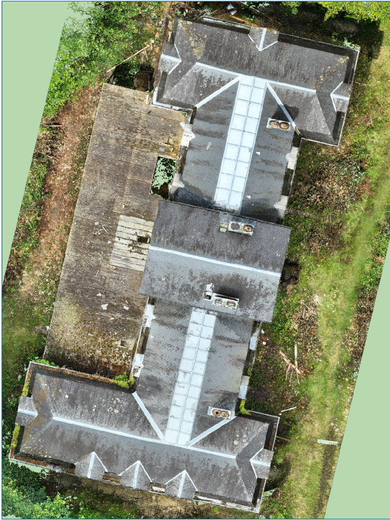
Orthophotographie des toitures issue de la photogrammétrie des images du drone
