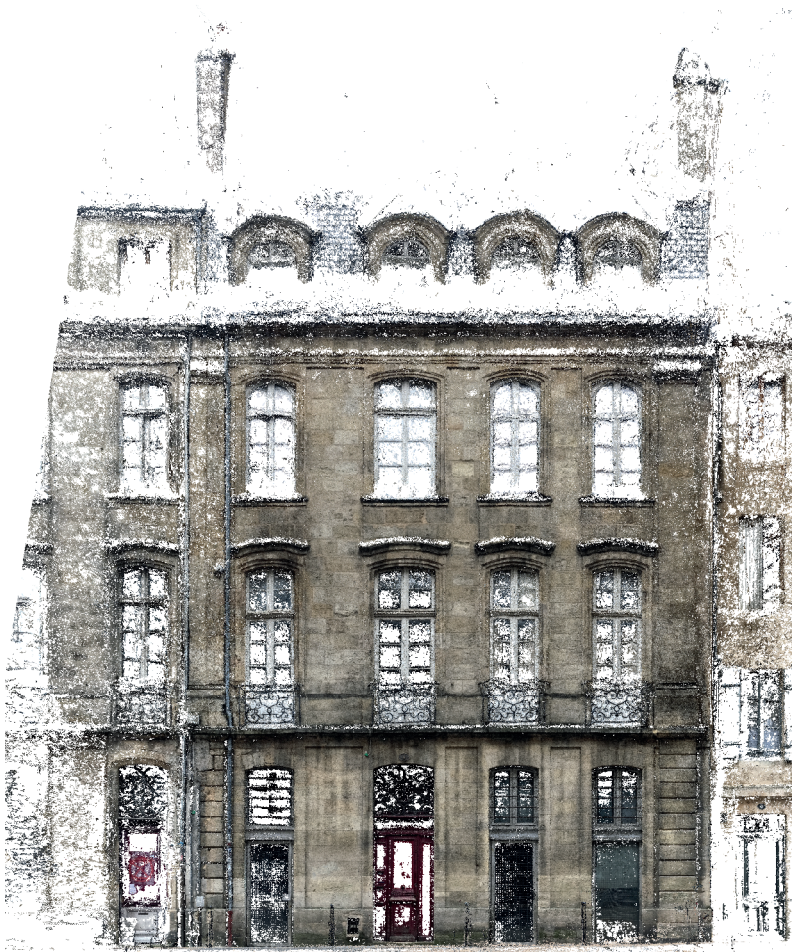
Ortho-image de la façade donnant sur la rue, réalisée à partir de photos d'un smartphone
